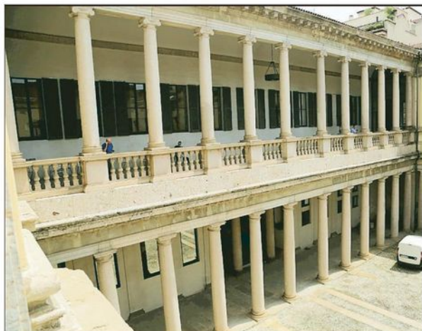
Il cortile dell'Archivio di Stato in via Senato
